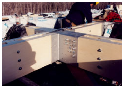
Figura 2 Legno Microlamellare in opera (dal sito www.cwc.ca , Canadian Wood Council)
